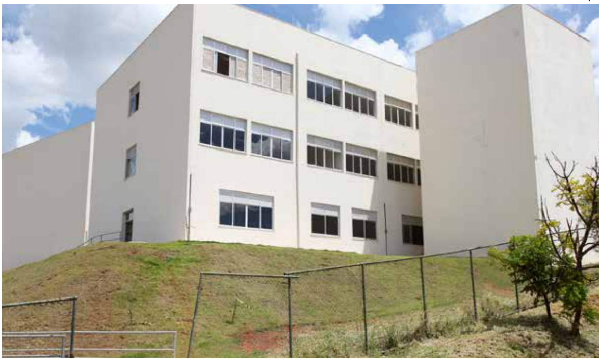
◆ Construção do Prédio II é um dos marcos na história do campus São João del-Rei do IF Sudeste
